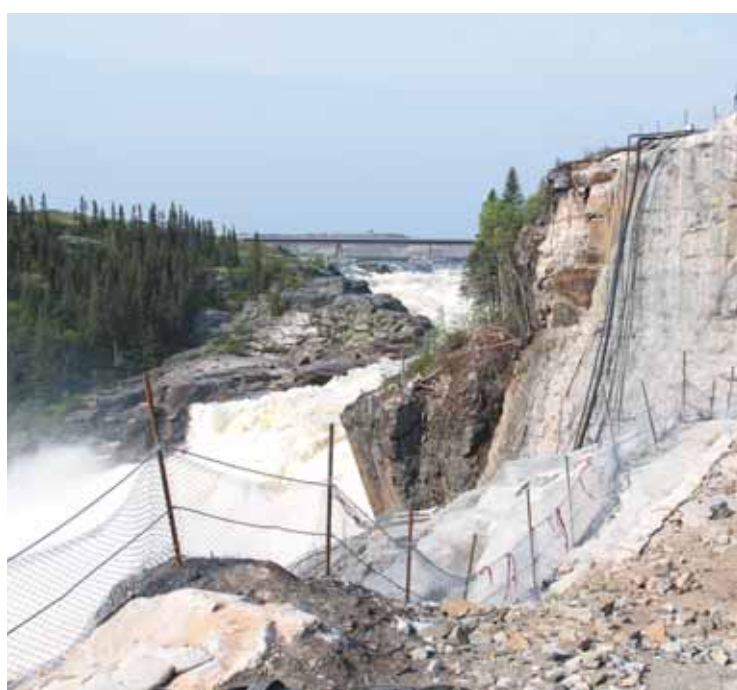
Sur les 2000 travailleurs qui se trouvent sur le chantier, environ 200 sont des Innus.
